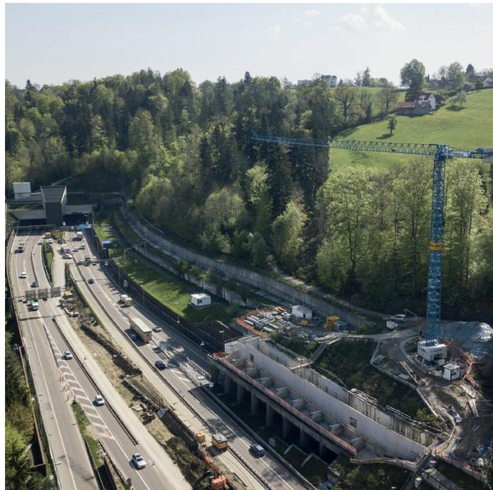
Die Vorarbeiten beinhalteten unter anderem die Erstellung von Überleitungssystemen und Notzufahrten sowie die Sicherung des Rutschhangs Dietli beim Anschluss Kreuzbleiche.
