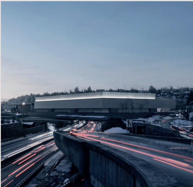
Die neue Halle 1 der Olma Messen wird über der Autobahn, östlich des Rosenbergtunnels gebaut.
